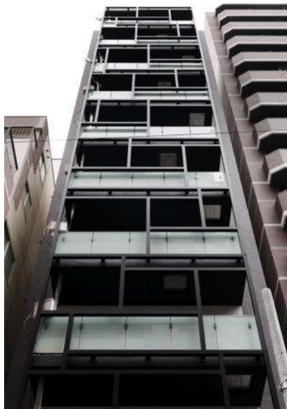
03_CAPS1022_202号室 外観西面
