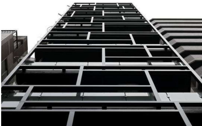
05_CAPS1028_202号室 外観西面
