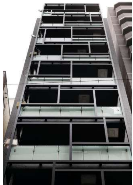
04_CAPS1026_202号室 外観西面
