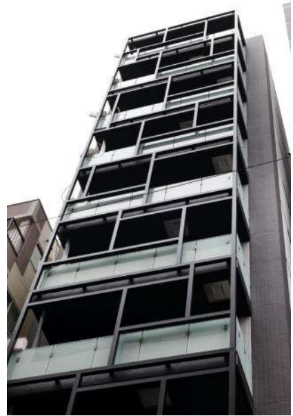
02_CAPS1019_202号室 外観西面
