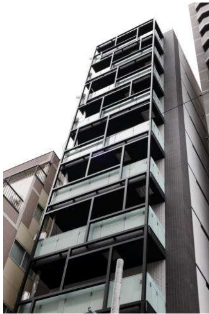
01_CAPS1016_202号室 外観西面
