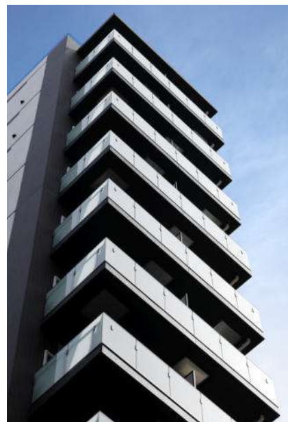
11_CAPS9472_南面 見上げ
