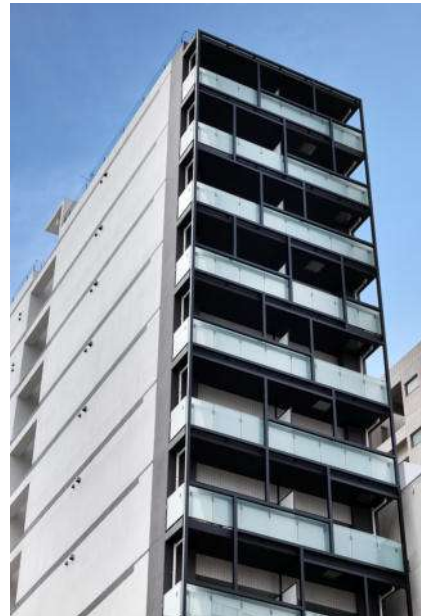
04_CAPS9539_北面 見上げ
