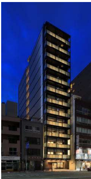
17_CAPS9986_外観北東(夜景)
