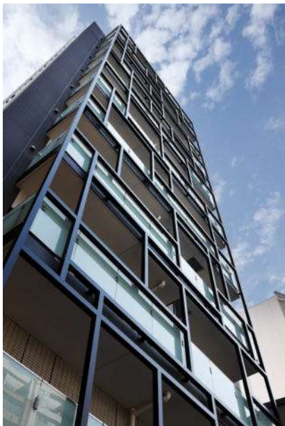
06_CAPS7114_北面 見上げ
