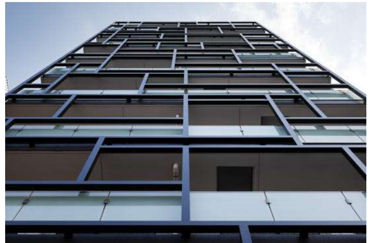
04_CAPS7134_北面 見上げ
