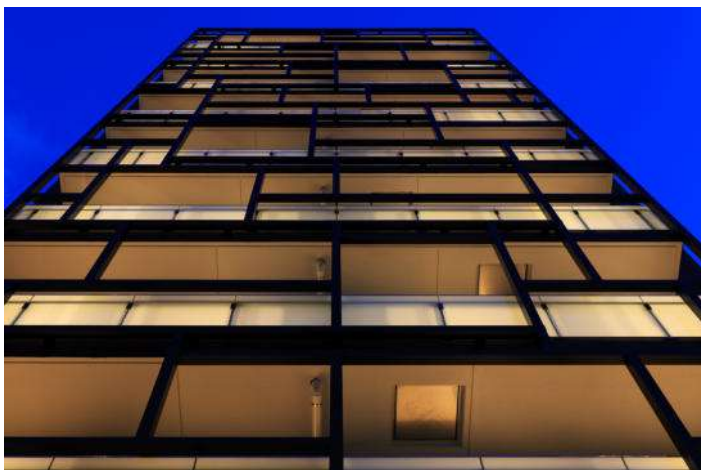
12_CAPS7418_外観 見上げ(夜景)
