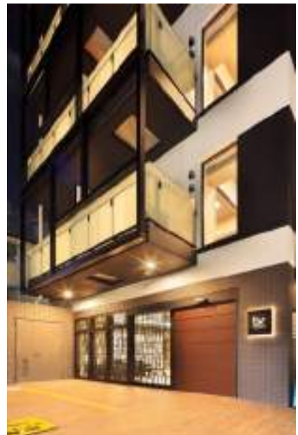
21_CAPS8006_エントランス廻り(夜景)
