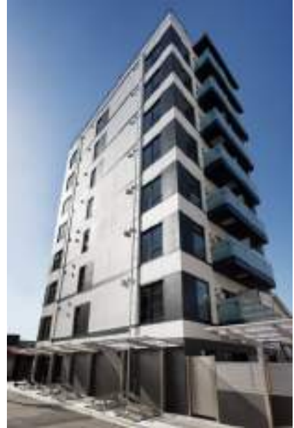
02_CAPS7466_外観北東面_修整
