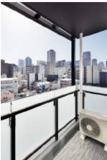
55_CAPS7606_701号室 バルコニー
