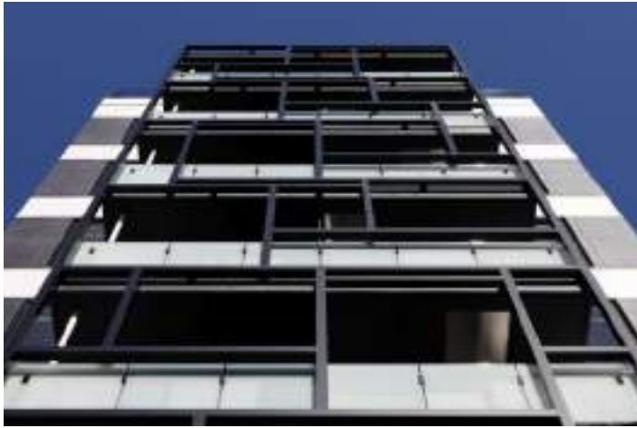
05_CAPS7481_南面 見上げ
