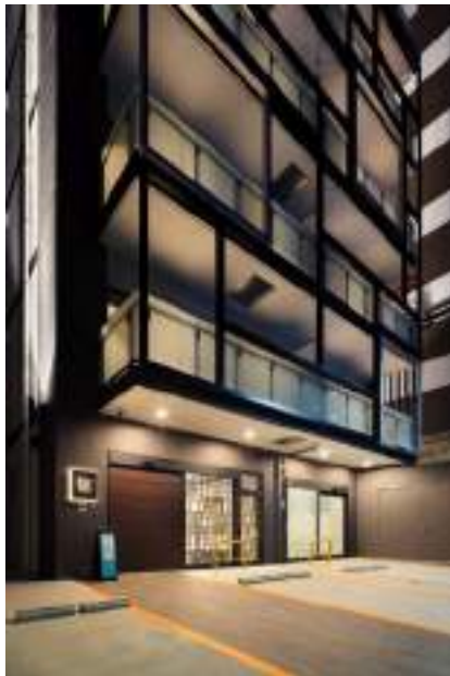
16_CAPS9212_エントランス廻り(夜景)
