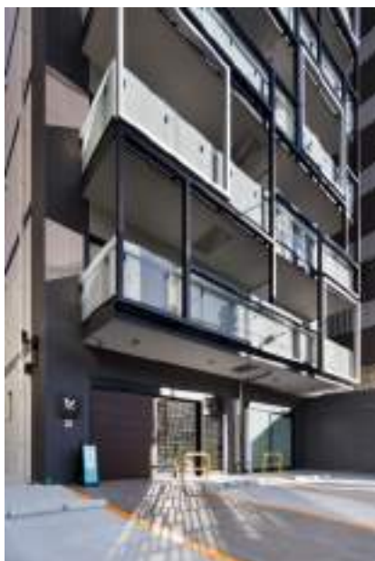
08_CAPS9059_エントランス廻り
