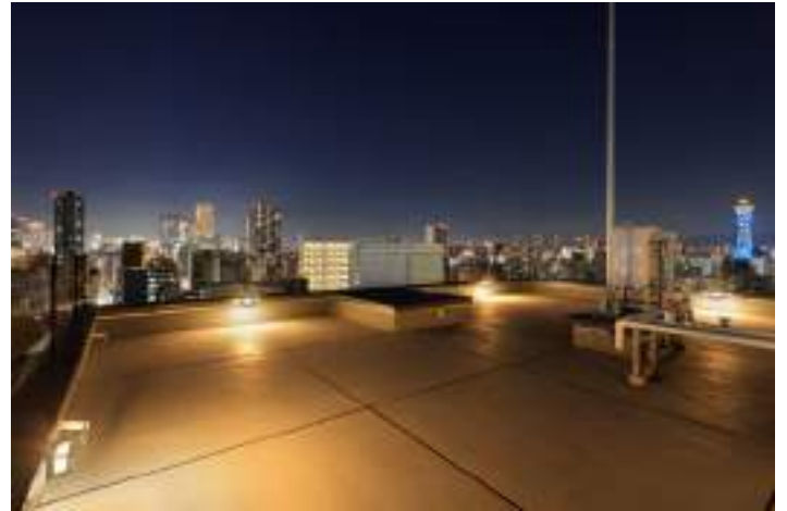
60_CAPS9276_屋上(夜景)
