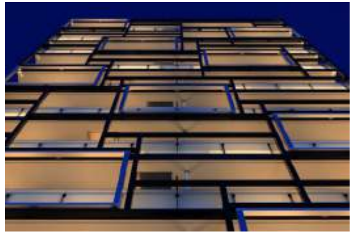
13_CAPS9169_西面 見上げ(夜景)
