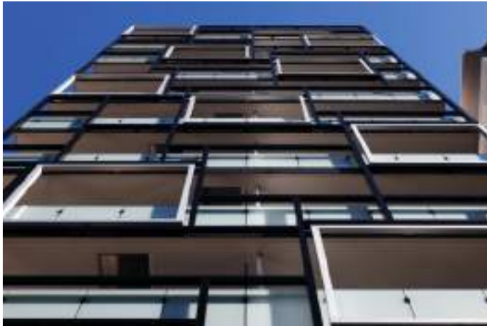
03_CAPS8967_西面 見上げ
