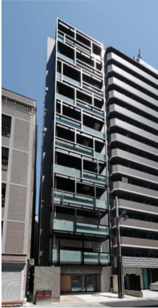
01_CAPS1884_外観西北面_修整
