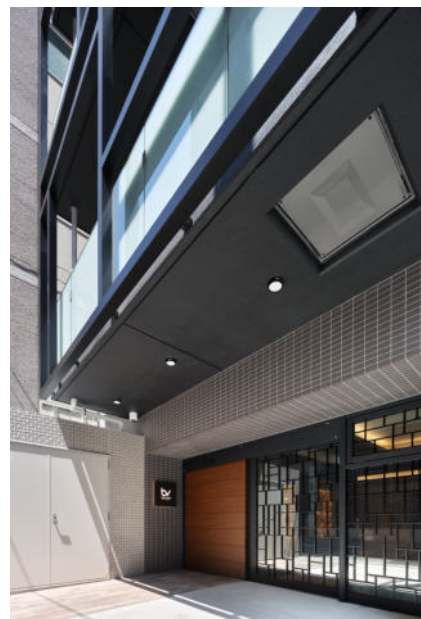
22_CAPS1909_エントランスポーチ
