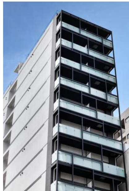
04_CAPS9539_北面 見上げ
