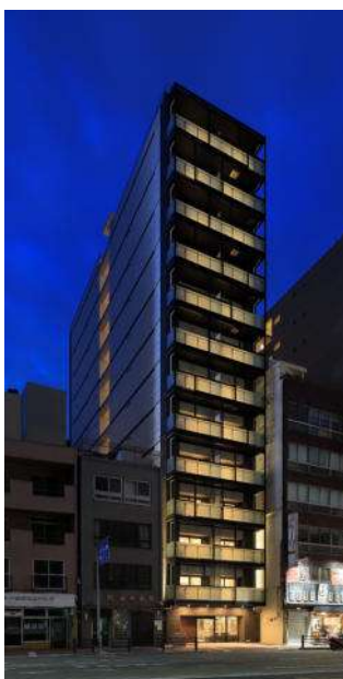
17_CAPS9986_外観北東(夜景)
