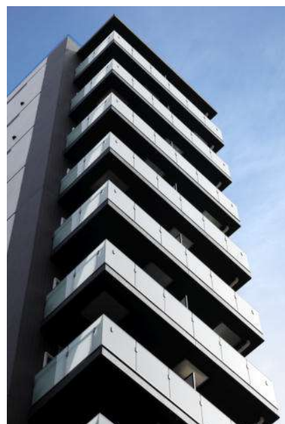
11_CAPS9472_南面 見上げ
