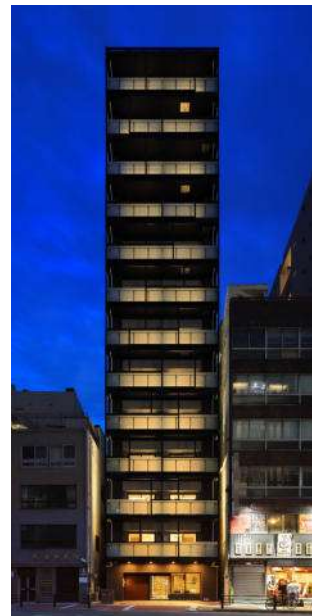
16_CAPS9978_外観北面(夜景)
