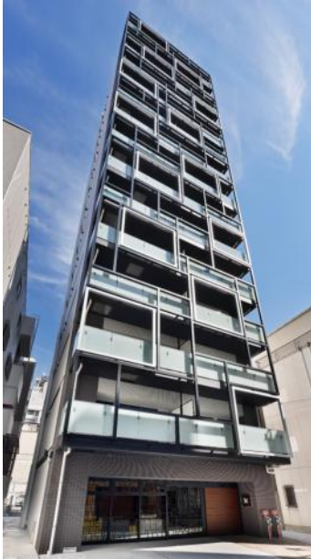
02_CAPS1782_外観西北面_修整
