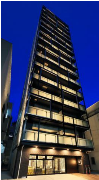
17_CAPS2050_外観西北面(夜景)_修整
