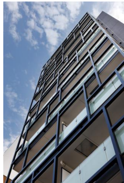
07_CAPS7124_北面 見上げ
