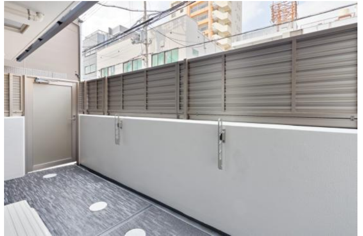
68_CAPS7179_101号室 バルコニー
