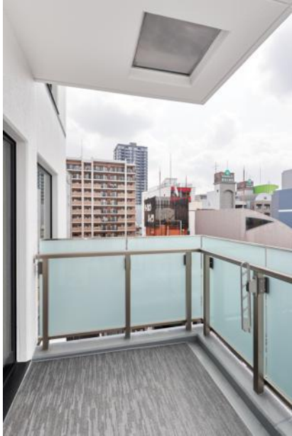
67_CAPS6928_903号室 バルコニー
