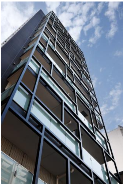
06_CAPS7114_北面 見上げ
