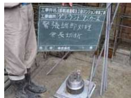
緊張端部処理
