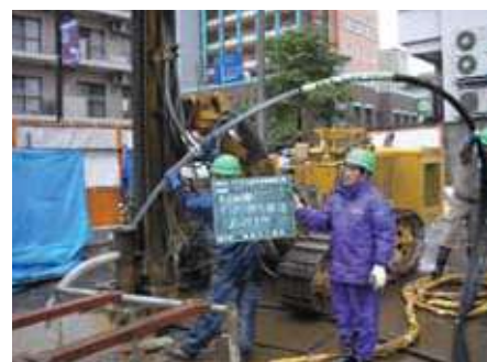
アンカー挿入状況
