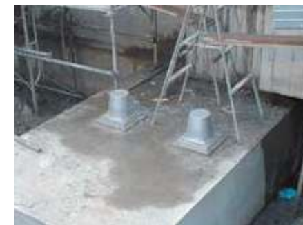
新設地中梁にアンカー打設
