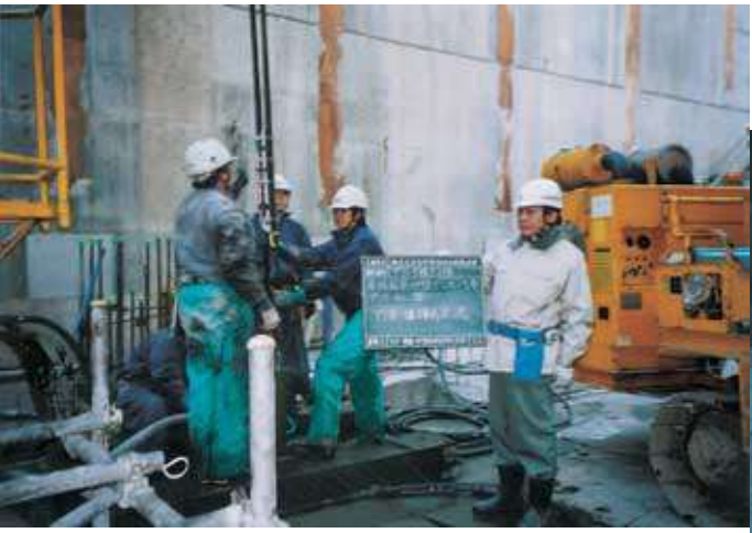
アンカー挿入状況
