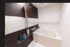
ユニットバス 天井照明 LED
