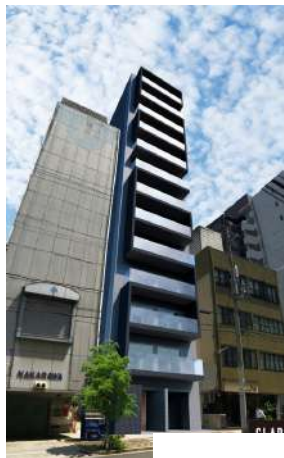
大手通2丁目PROJECT（仮称）の完成イメージ（資料：ブエナビスタ）
